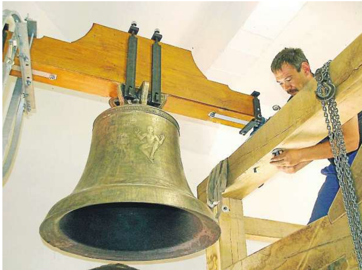
Rainer Stark von der Glockenbaufirma Bachert montiert die Auferstehungsglocke.
